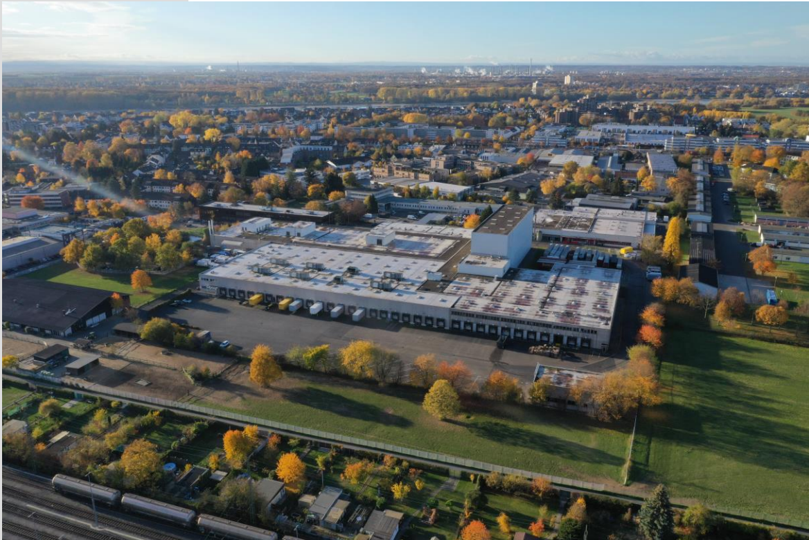
Luftbild Bestand - Neubaufäche
